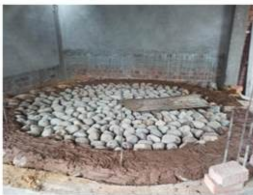
IMAGEN DE BASE PARA BORDE DE LADRILLOS CONICOS / FUENTE: “PANADERÍA ARTESANAL SAN ROQUE”
