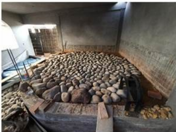
IMAGEN DE BASE DE PIEDRAS / FUENTE: “PANADERÍA ARTESANAL SAN ROQUE”
